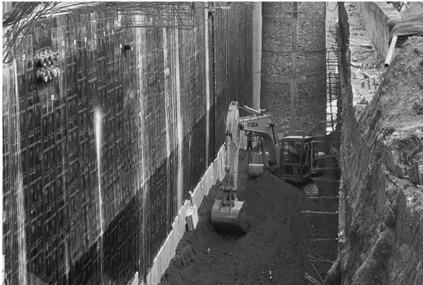
图为正在进行二期(商业)肥槽回填和防水施工作业
