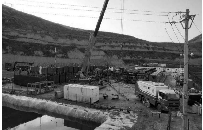
图为钻采公司压裂5队进行致密油华H35平台2井第16~17段压裂作业
