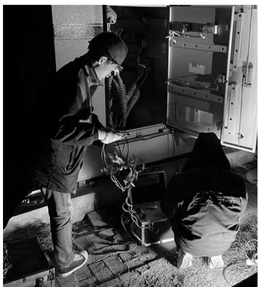
4月12日,在环县20MW光伏扶贫电站一处箱变,工程师们为了保证白天发电不受影响,趁着夜色加班加点进行设备检修。(赵鹏 摄)
